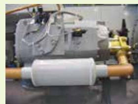
排气管路消音器
